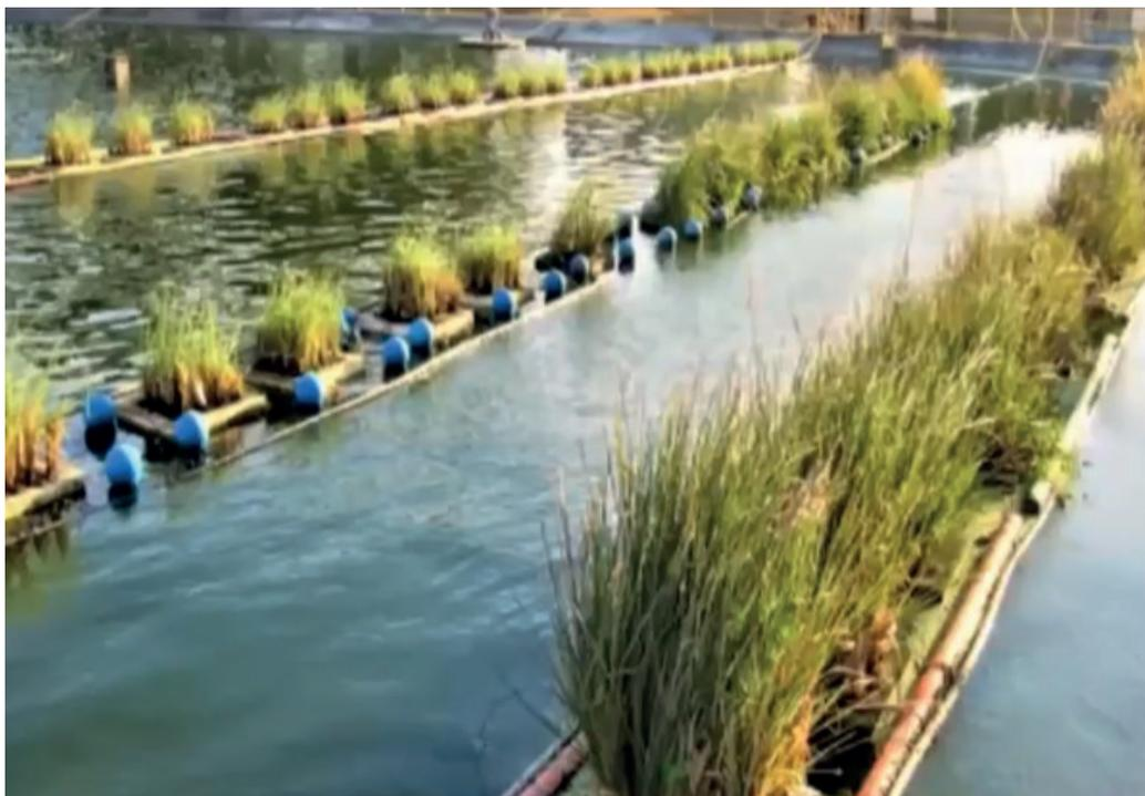
**Figura 2. Plataformas flotantes para el tratamiento de aguas residuales en humedales**
